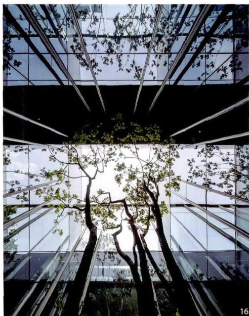
隐了结构感。为了加强室内外渗透的效果，设计师在悬挑的铝板屋檐下设置了与玻璃面垂直阵列的凹形灯槽，利用反光原理营造了屋顶的内外联通效果。除此之外，设计师还在玻璃幕墙外设置了建筑的第二层表皮，即一系列可旋转开闭的屏风。这一设置不仅在视觉上增强了建筑立面的进深感，进一步削弱了玻璃分缝带来的视觉阻碍，同时还在建筑节能与文化属性上提升了建筑品质。
